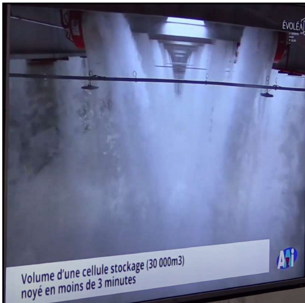
Dispositif d'anéantissement de feu par projection de mousse haut foisonnement
